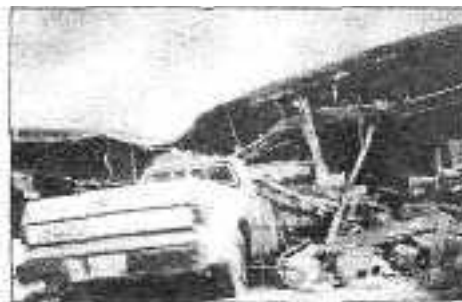
Взрывная волна обрушила шлакоблочное сооружение, стоявшее в трех блоках к северо-западу от федерального здания. В результате этого взрыва около 17 зданий в этом районе стали непригодными для проживания
